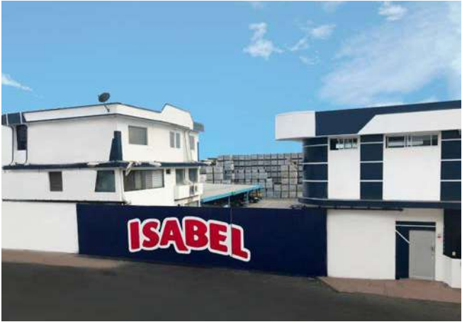
Planta de Manta. Ecuador
