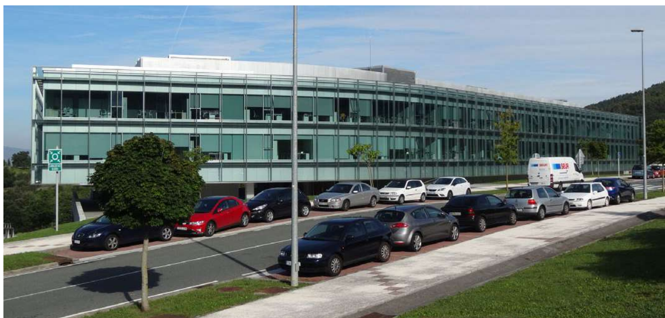
Oficinas centrales en Zamudio, Vizcaya
